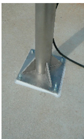
Flensbevestiging direct op het dakvlak
